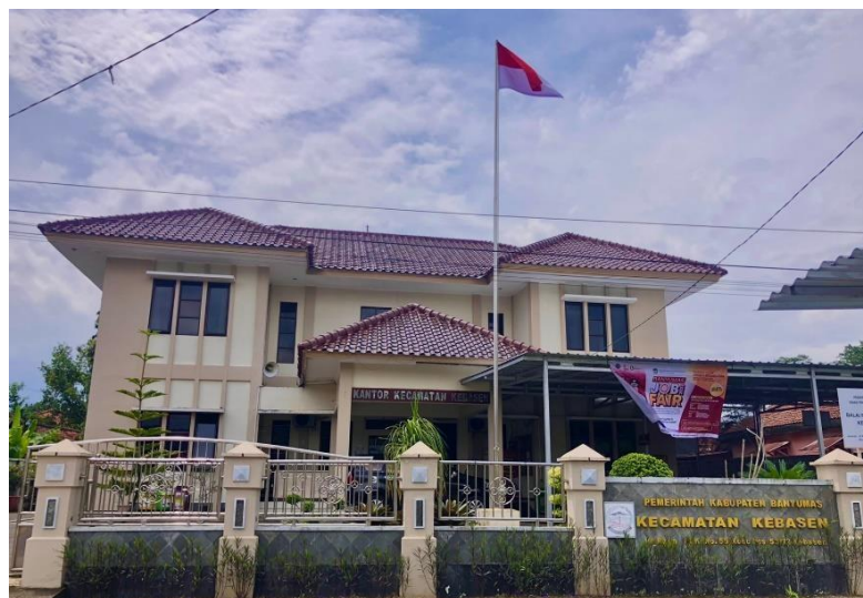
Gambar 2. 1 Gedung Utama Kantor Kecamatan Kebasen
